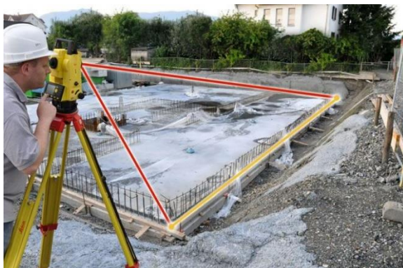
Figura 4. Replanteo con taquímetro y levantamiento As-built
